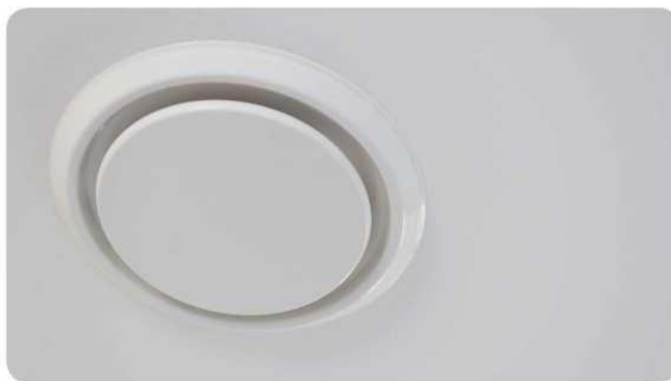
Foto: voorbeeld ventilatieventiel
