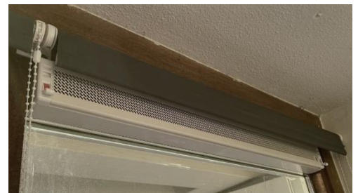
Ventilatierooster boven het nieuwe glas.
