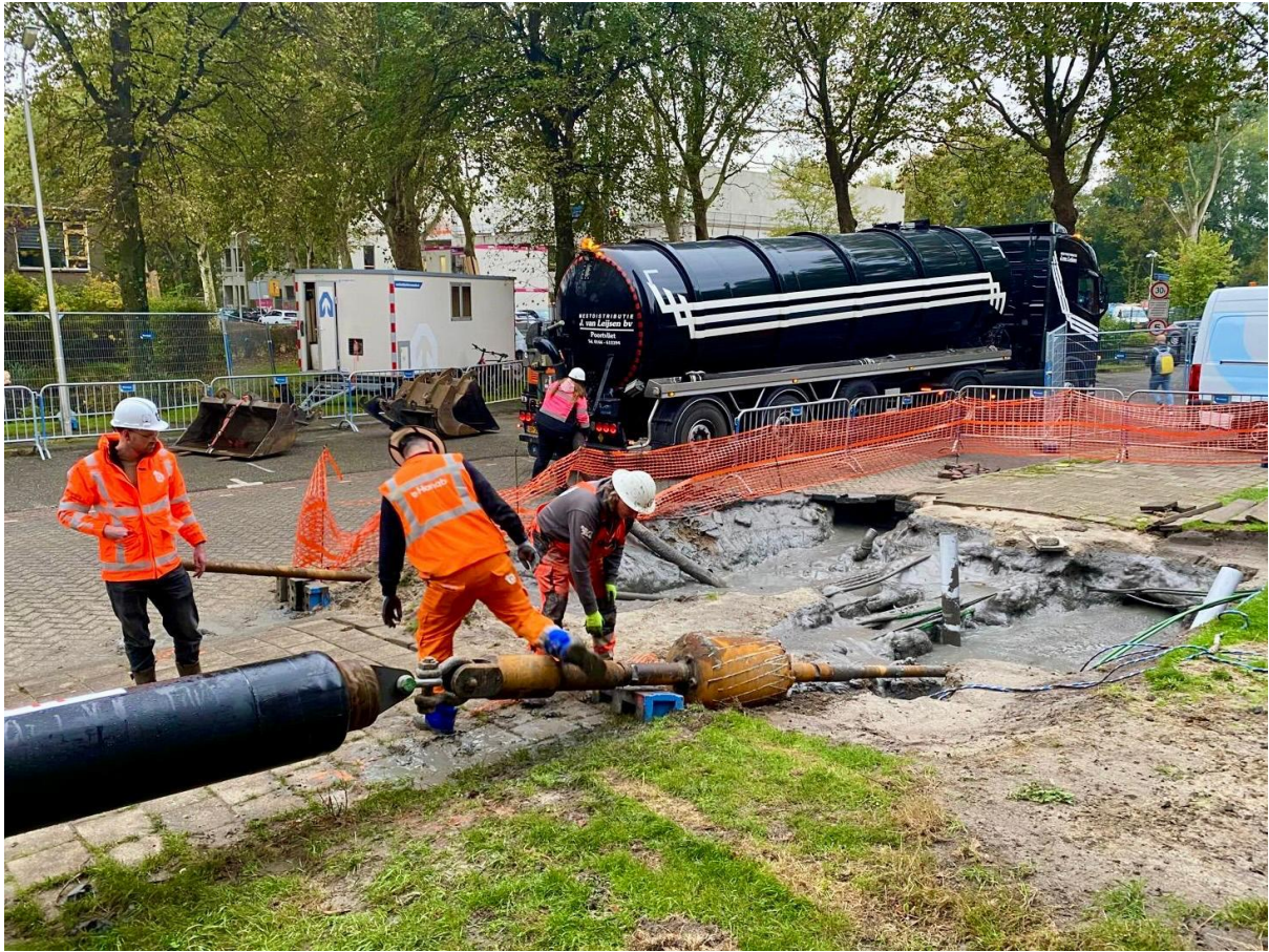
Aanleg warmtenet Delft
